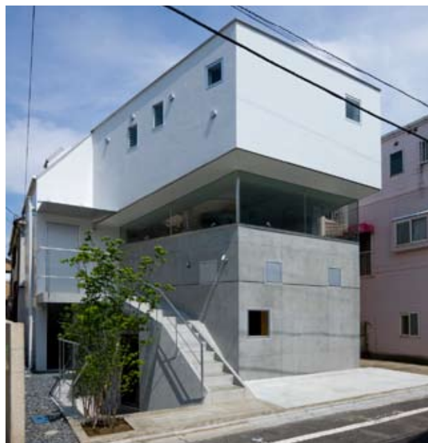
左:「TRAPEZIUM」北西の前面道路側より見る。2階の迫り出したボリュームの外壁にハイドロテクトカラーコートECO-EXが使われている。右上:1階住宅部分と地階のホールへのアプローチ。右下:地階のホールは建主の友人のアーティストがコンサートや演劇に使える。
